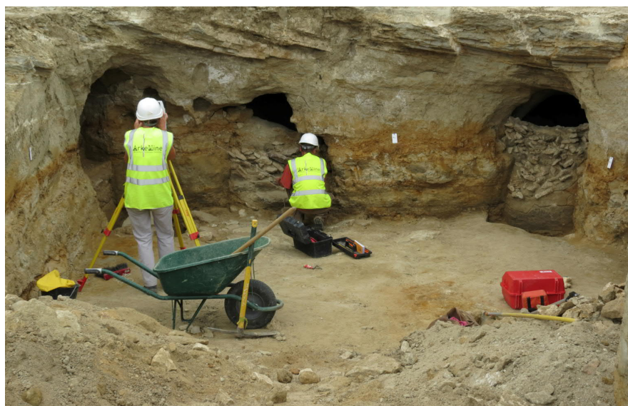
Fig. 1 : Zone effondrée du souterrain 4 du site de la Renferme (Marigny-Brizay, Vienne) en cours de fouille (crédits : Arkemine).
